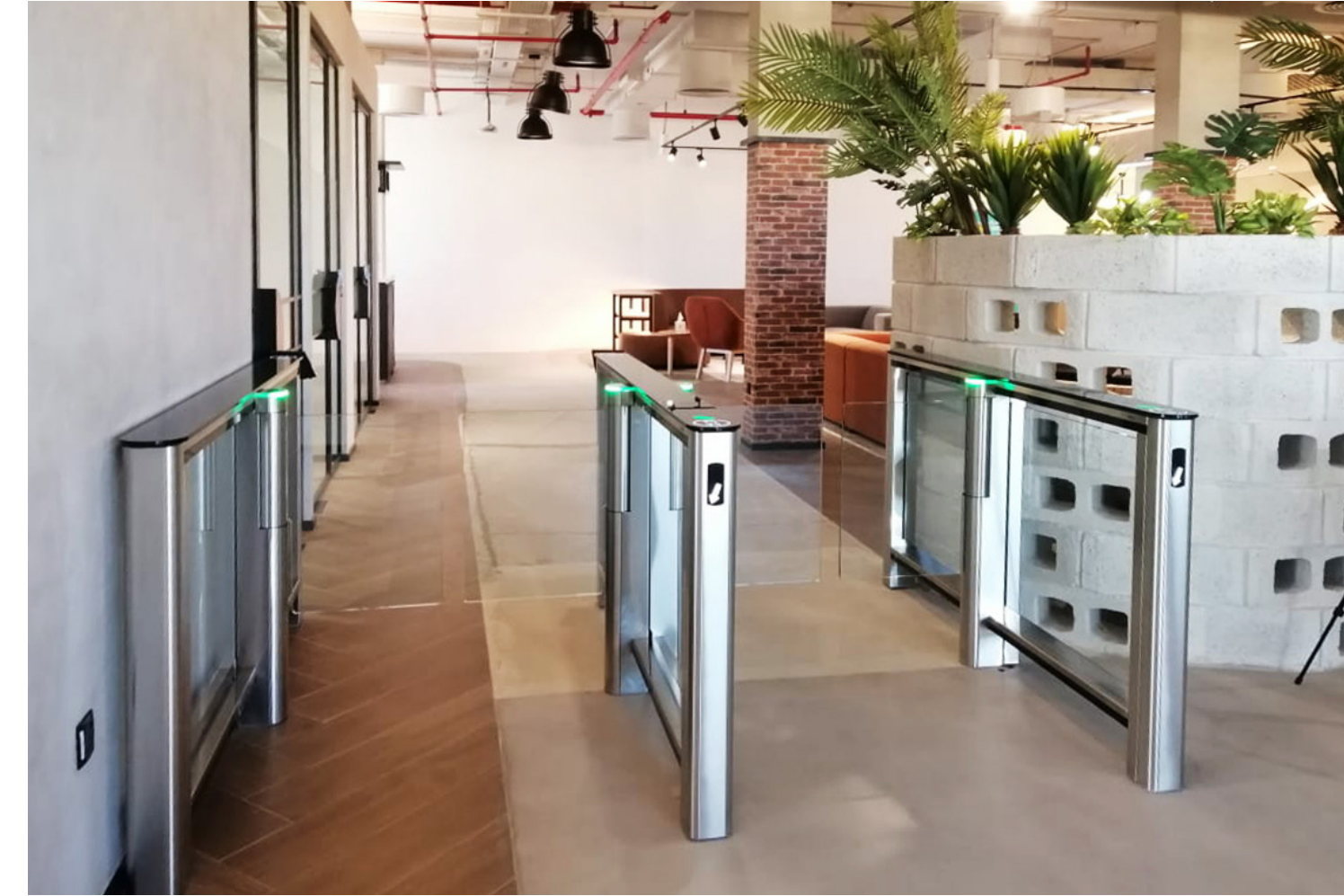
Pasillos rápidos ST-01, Sede de RAKEZ, EAU
